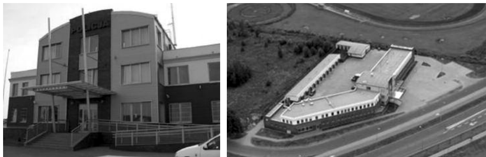
Fot. 5 i 6. Nowa siedziba KPP w Człuchowie
